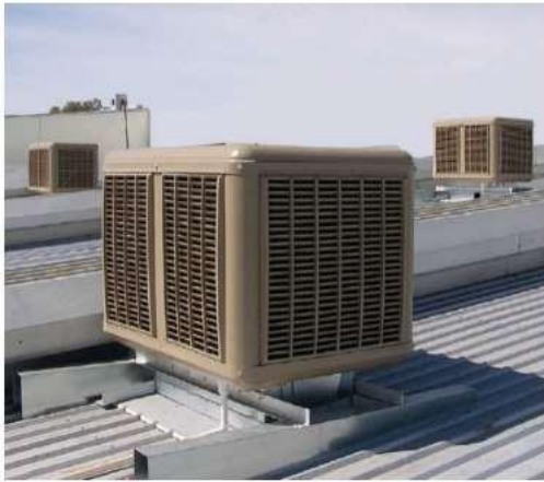
Debido a su poco peso, no es necesaria una grúa para su montaje, ni soporte para su instalación, bastando con su propio conducto
